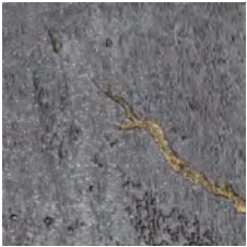
床 PM22179 トイレの床だけ他と変えることで排泄をルーティーンから切り離れた。
